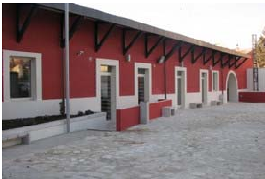
Fig. 71. L'ex mattatoio comunale: prospetto sul cortile interno
