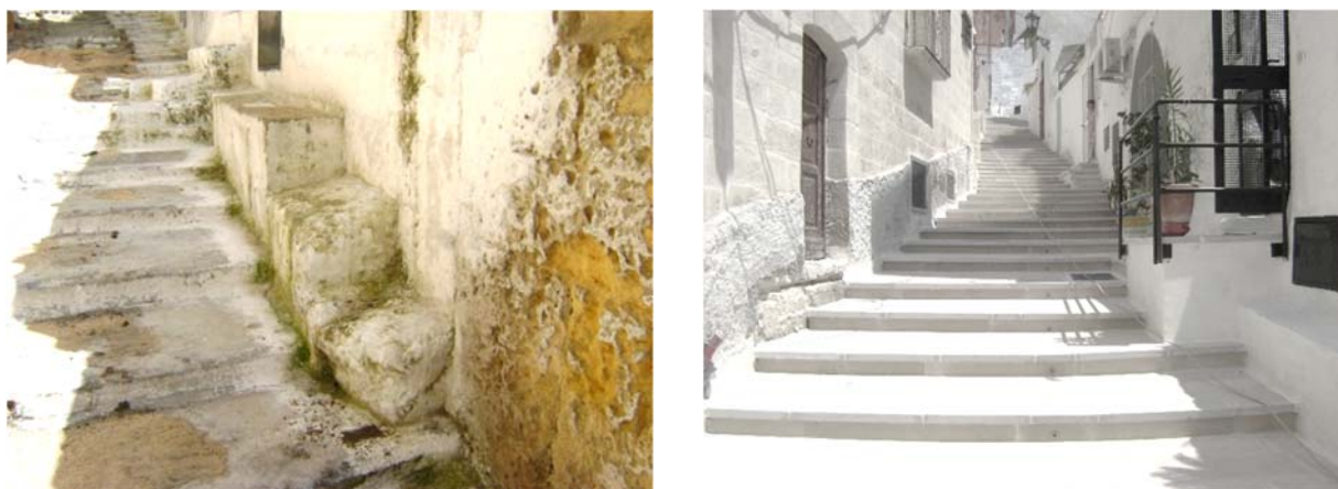
Fig. 105. Una delle scalinate prima (sx) e dopo (dx) l'intervento di recupero
