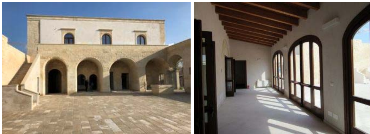
Fig. 45. La Masseria Tagliatelle: veduta dall'esterno e particolari degli interni
