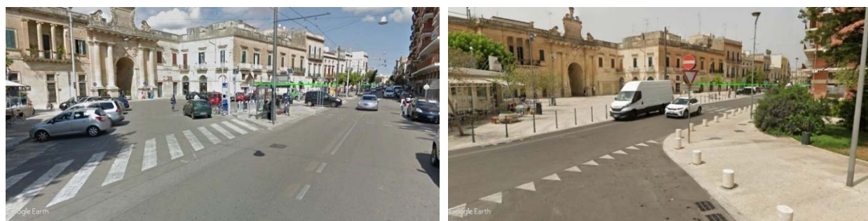
Fig. 49. L’area di Porta San Biagio prima (sx) e dopo (dx) gli interventi di riqualificazione
