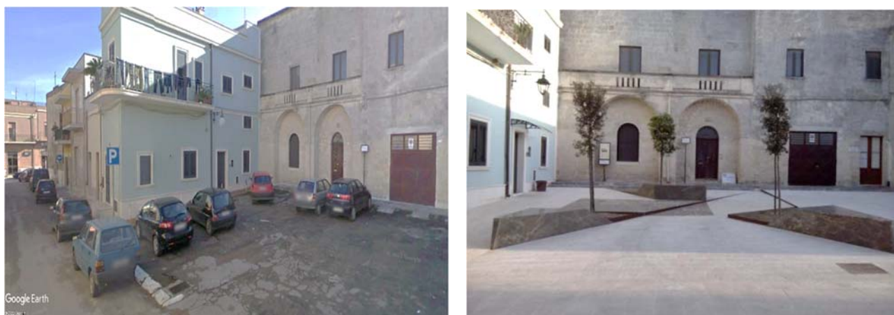
Fig. 78. Piazza del Palazzo Arcivescovile prima (sx) e dopo (dx) l’intervento
