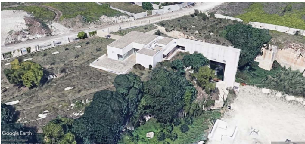
Fig. 43. L'edificio destinato ad ospitare la caffetteria del Parco delle cave
