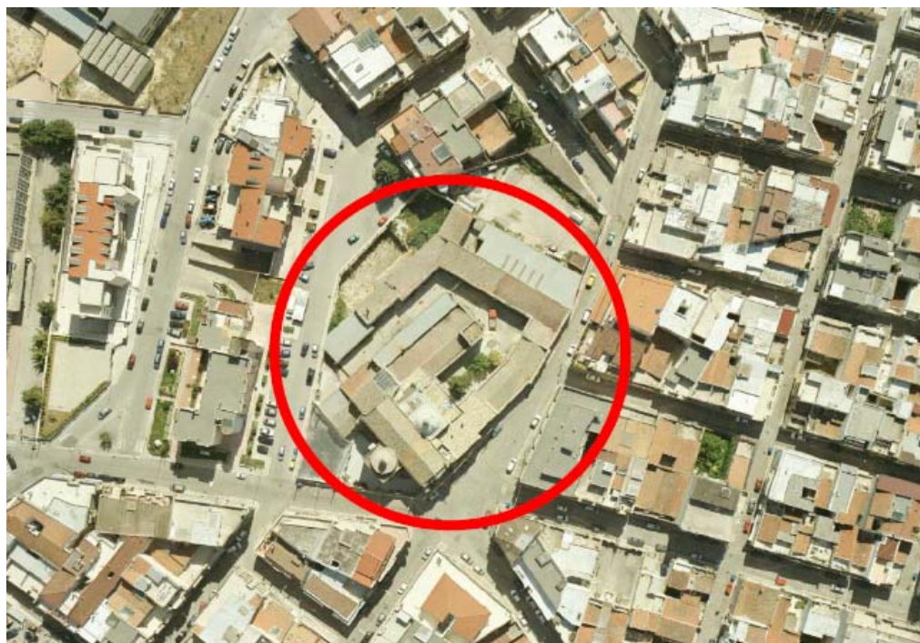
Fig. 70. La localizzazione dell'ex mattatoio comunale
