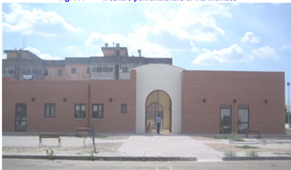
Fig. 77. Il centro polifunzionale di Via Manisco
